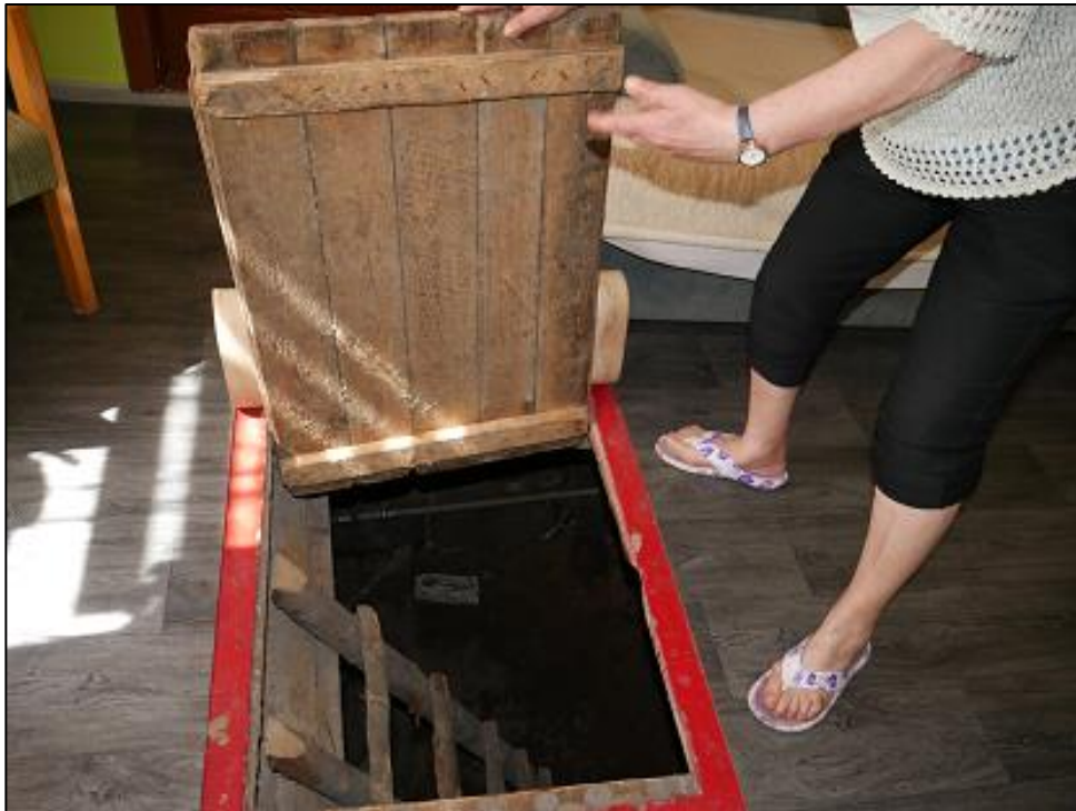
zejście do piwnicy z pokoju nieogrzewanego (przejściowego)
