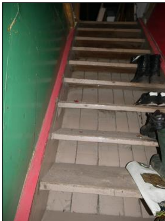
wejście na strych (pod schodami łazienka)
