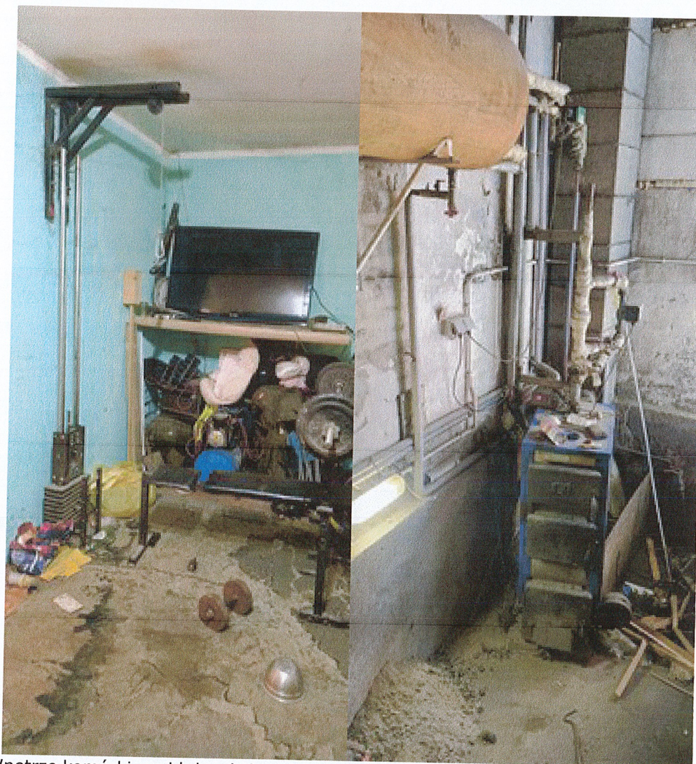
Wnętrze komórki znajdującej się w budynku gospodarczym na działce numer 575/37
