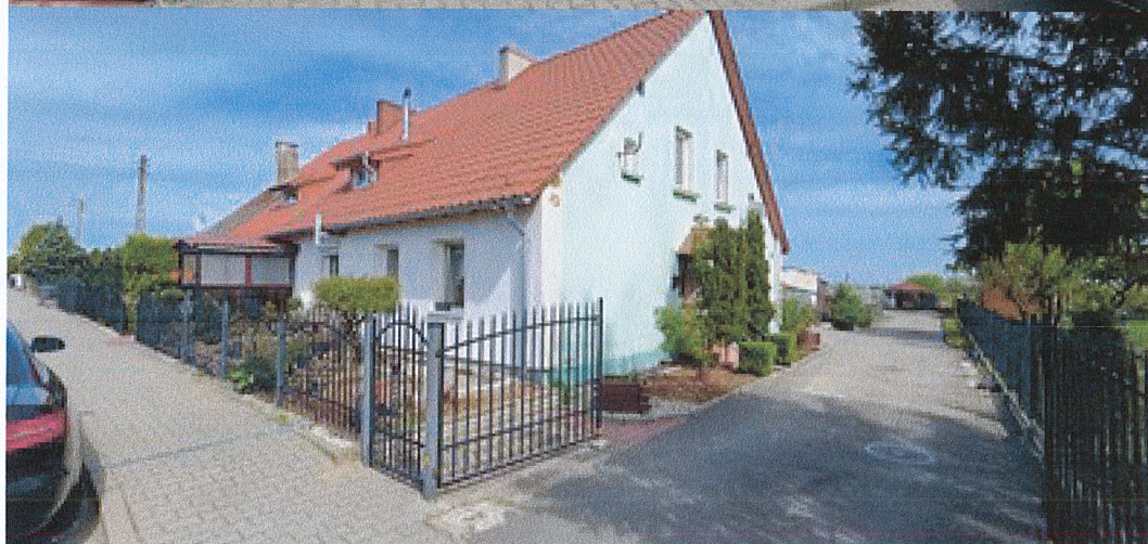
Budynek w którym znajduje się wyceniany lokal
